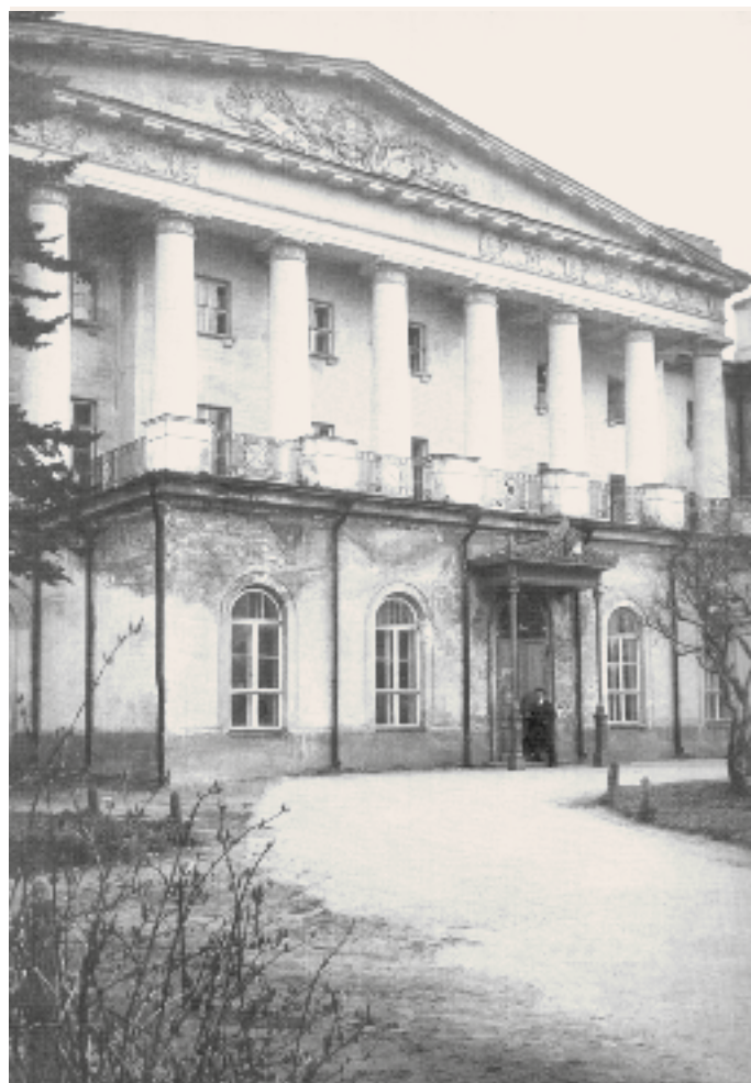
Центральный вход ЦДКА до начала ремонта и перестройки главного здания, апрель 1927 г.
