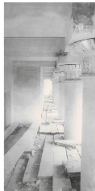
Ремонт на 3-м этаже, октябрь 1927 г.
