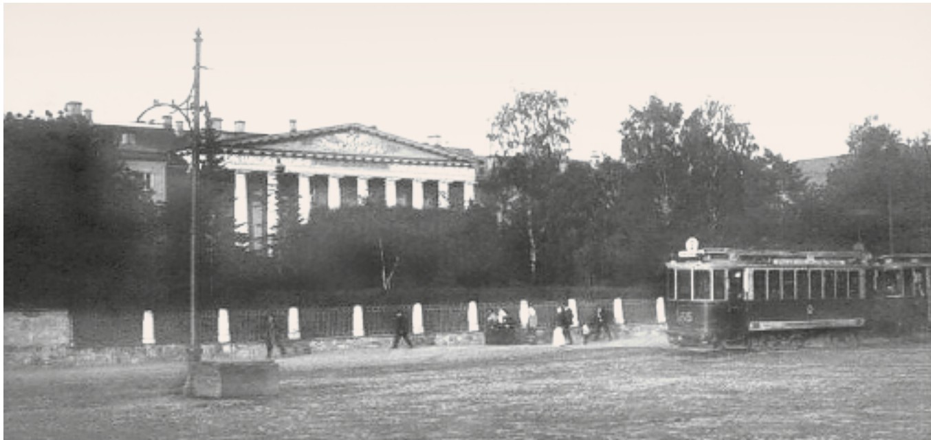
Вид на Дом с площади Коммуны в 1920-е годы, когда в нём располагался Центральный Дом коммунистического воспитания рабочей молодёжи
